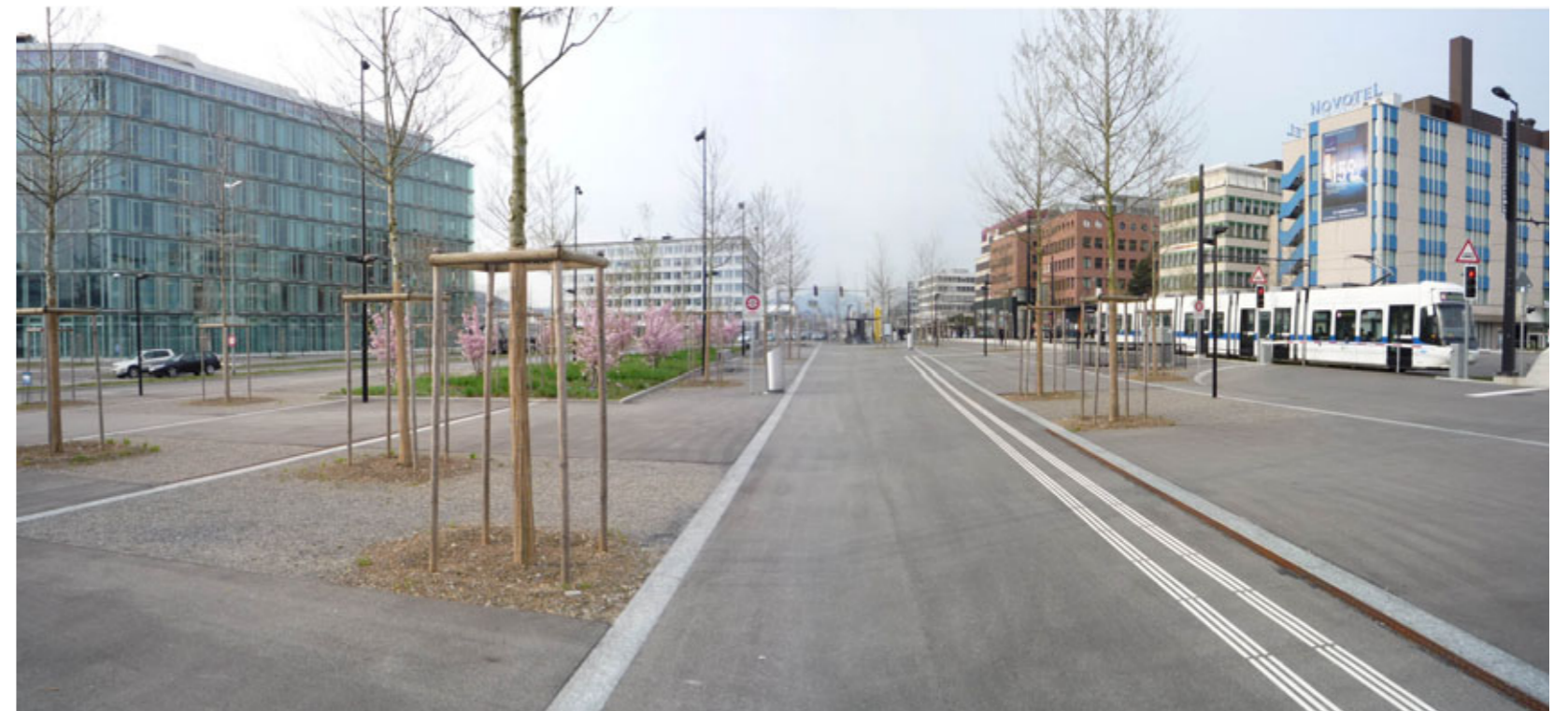
Blick in die Achse der südlichen Thurgauerstrasse: Junger Pappelhain mit Platzleuchten. Granitbänder gliedern die Fläche und erzeugen die Prinzipien für Baumscheiben, Entwässerung, Markierungen
