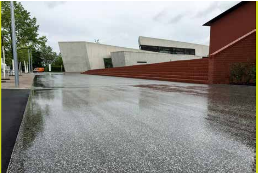
Mit dem System Divico Kleweg bearbeiteter Asphaltbelag beim Vitra Depot in Weil am Rhein.
