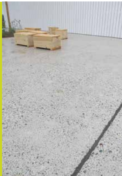
Mit dem System Divico Kleweg bearbeitete Betonoberfläche.
