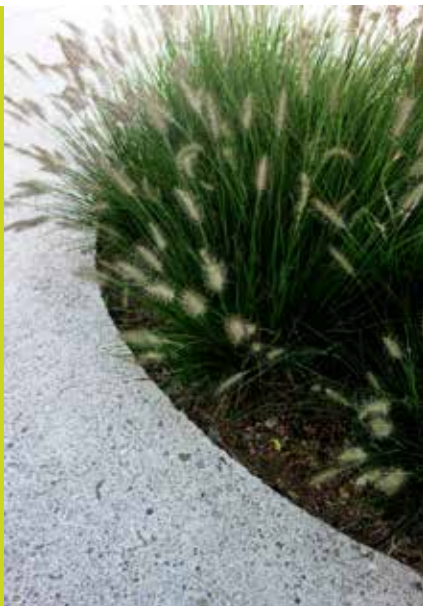
Betonplatten ermöglichen organische Formen. Achtung: Rissgefahr.
